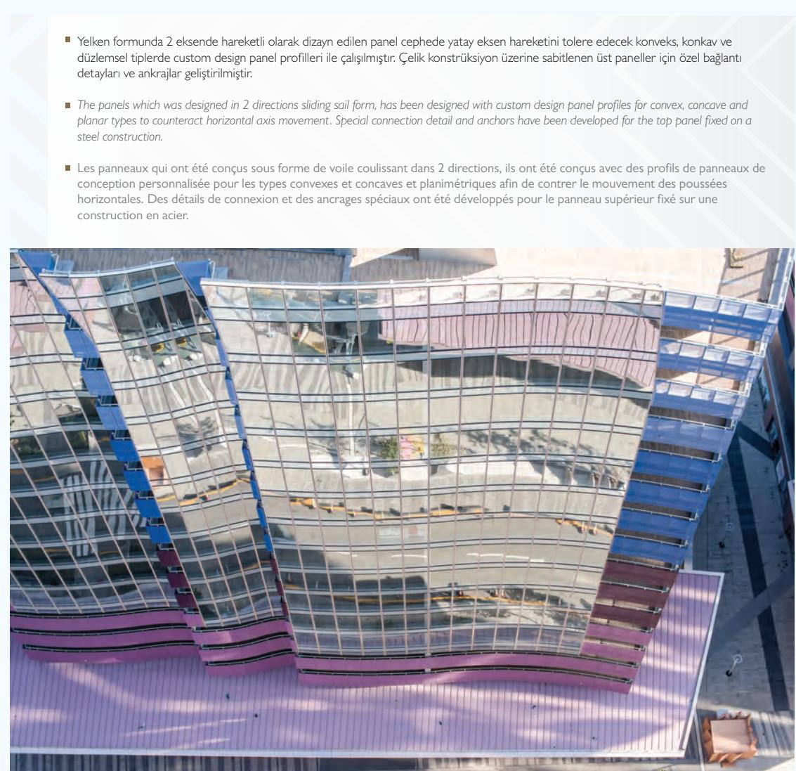
■ Yelken formunda 2 eksende hareketli olarak dizayn edilen panel cephede yatay eksen hareketini tolere edecek konveks, konkav ve düzlemsel tiplerde custom design panel profilleri ile çalışılmıştır. Çelik konstrüksiyon üzerine sabitlenen üst paneller için özel bağlantı detayları ve ankrajlar geliştirilmiştir.
