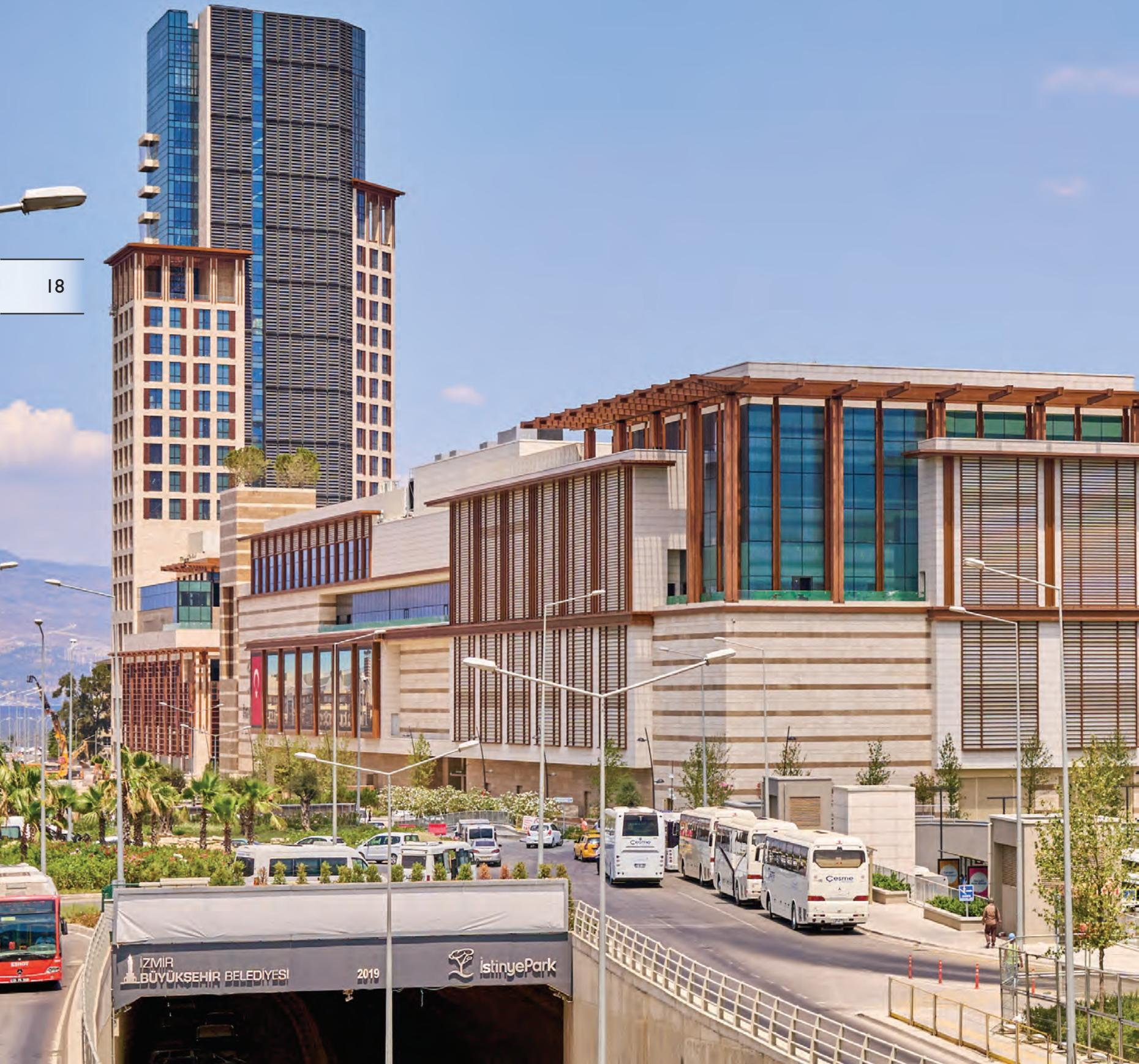
İstinye Park AVM İzmir'de inşası tamamlanan projede kompozit panel kaplama, menfez, cam saçak, saçak, alüminyum silikon giydirmeye cephe, cam korkuluk, mesh kaplama, cam finli spider cephe, paslanmaz çelik rüzgarlık, asansör spider cam kaplama işlerinden oluşan 18.500 m<sup>2</sup> uygulama yapılmıştır.
