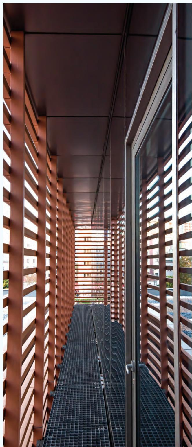
■ Terra cotta baget elemanlar ile oluşturulan güneş kırıcı arkalarında kediyoğu uygulaması yapılarak cam temizleme imkanı sağlanmış ve havalandırma alanları elde edilmiştir.
