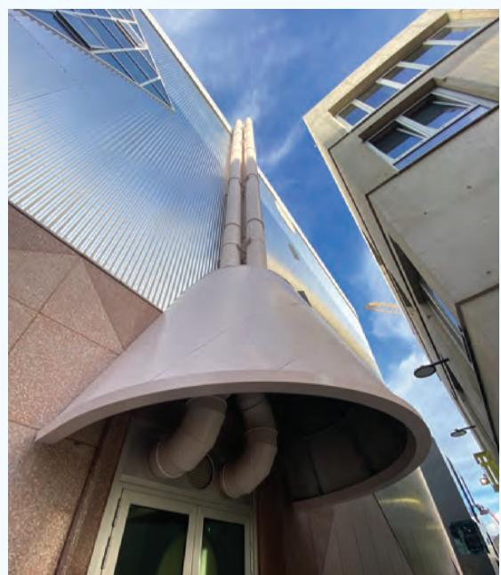
■ 6A Architects tarafından dizayn edilen A2 ve B2 Blokta, cephe ve doğrama yanında, Terrazzo kaplama, oluklu panel kaplama, konik giriş saçlığı vb. cephe uygulamaları TUNA YAPI tarafından tamamlanmıştır.
